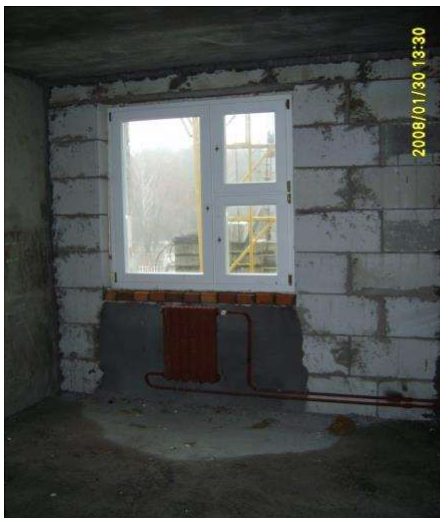
Установка оконного блока и разводка системы отопления
