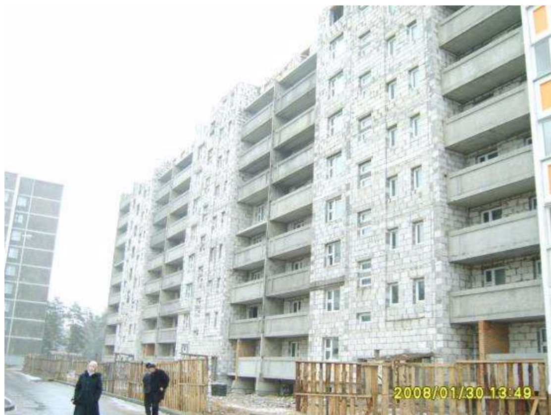
Строительство девятиэтажного дома №14 (ДСК)
