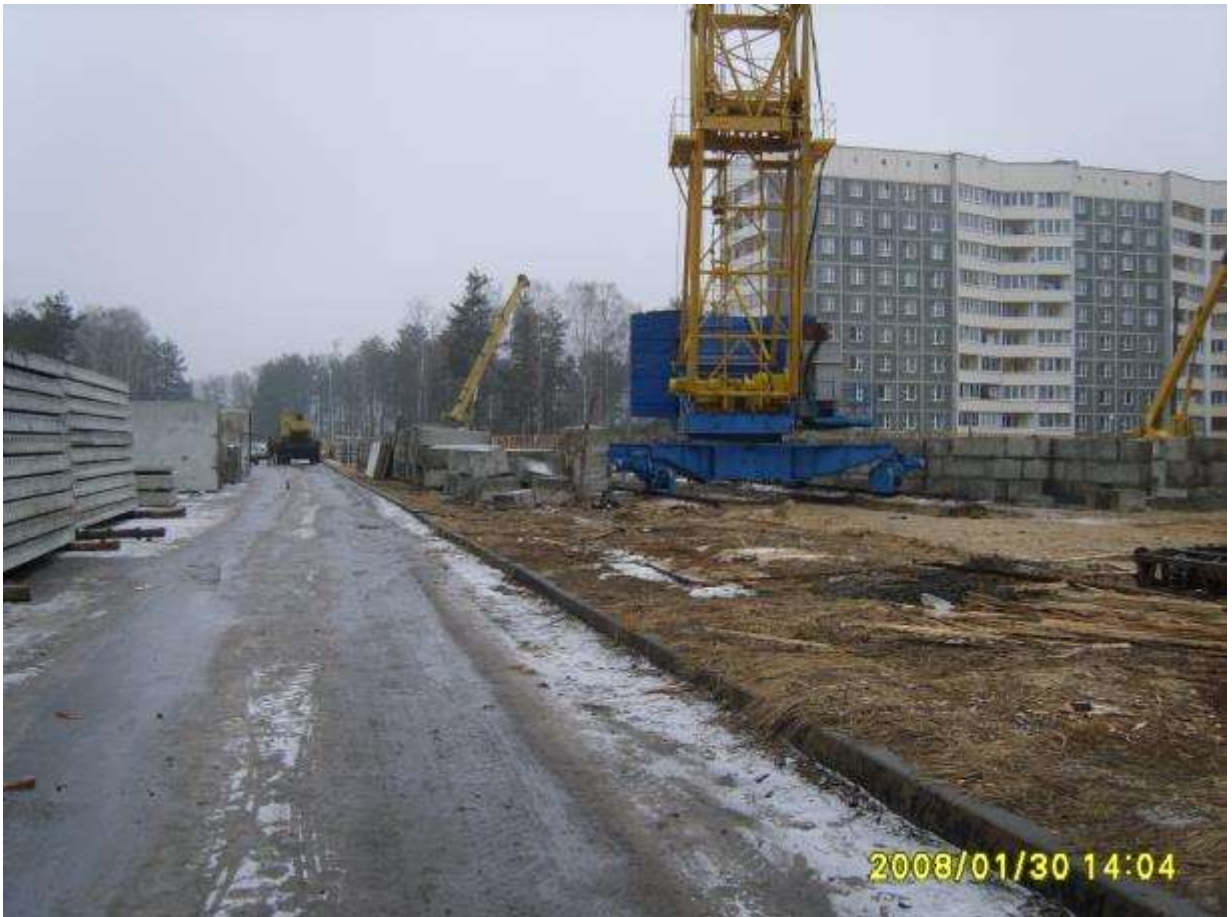
Строительство комплекса домов (5,7 и 9 этажных)
