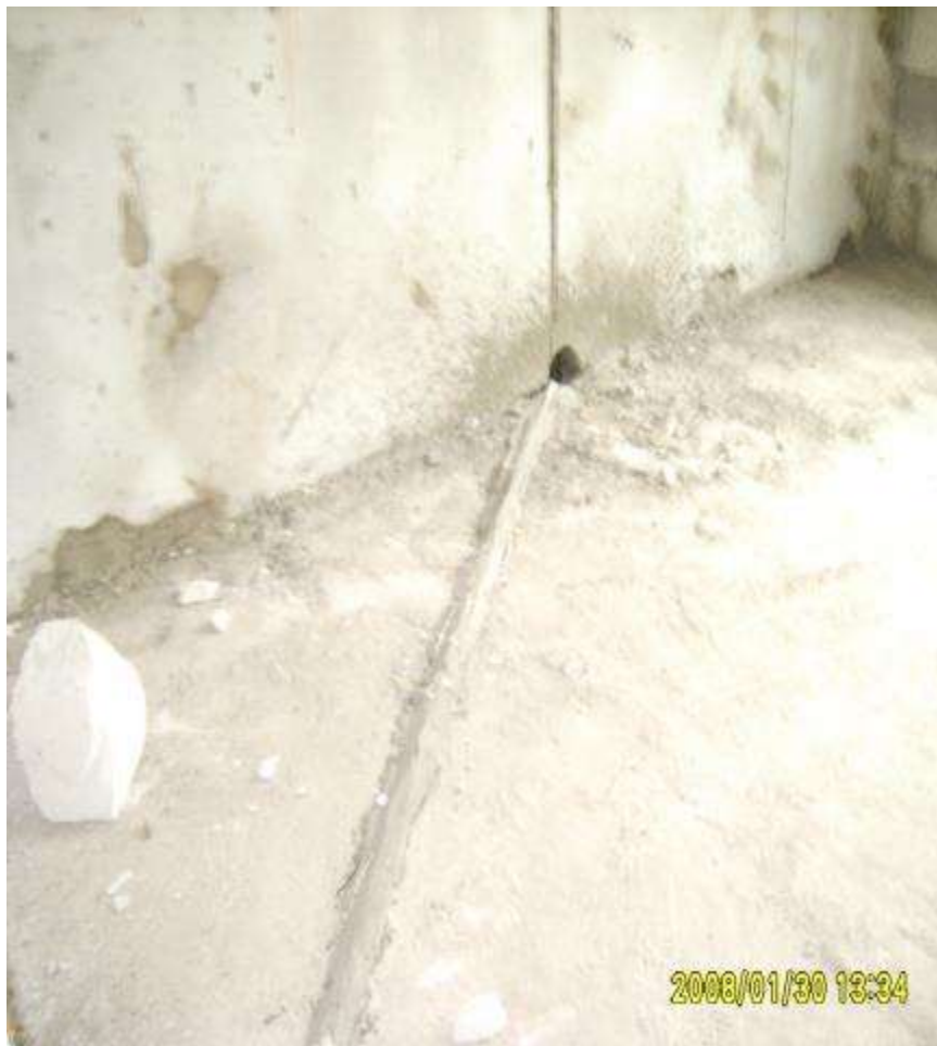
Установка оконного блока и раскладка кабеля по полу
