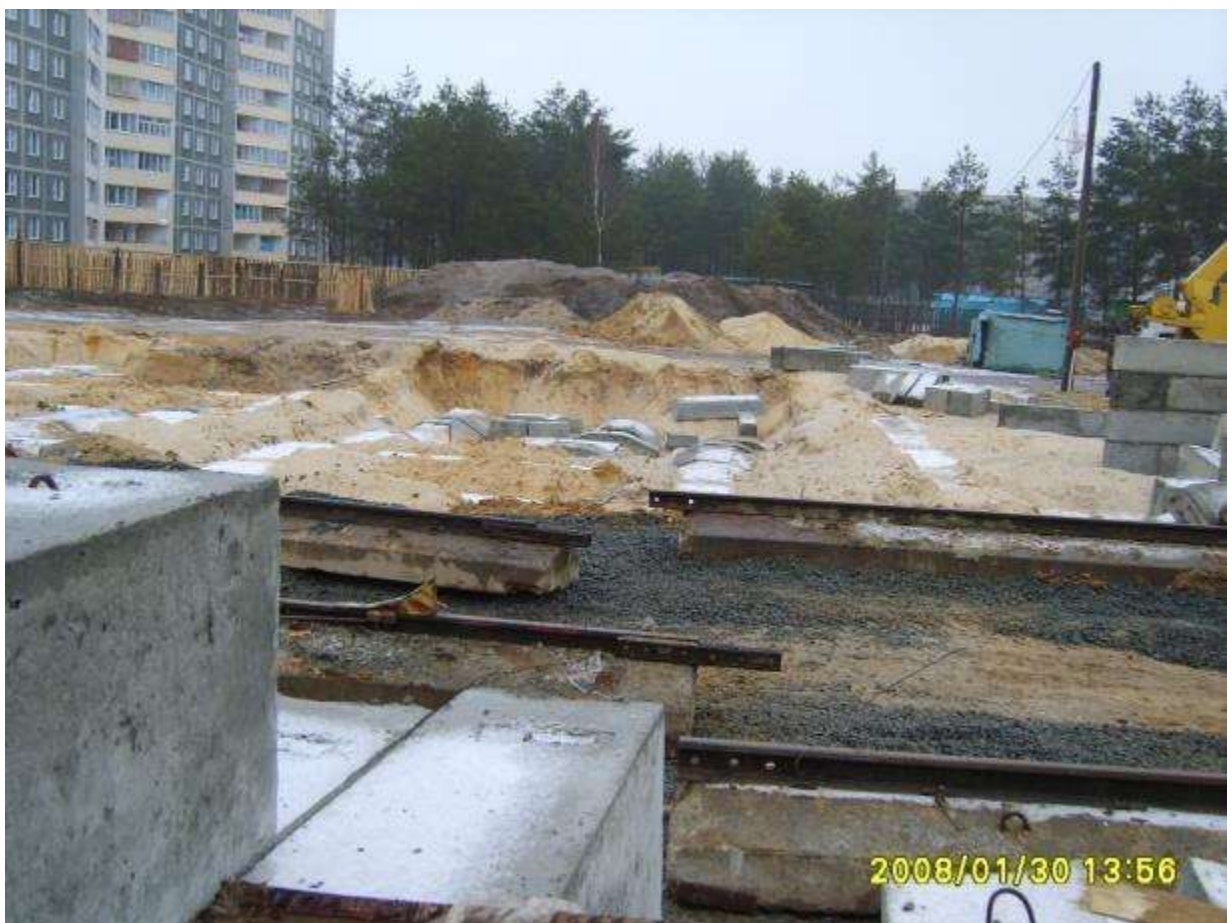
Монтаж подземной части комплекса зданий
